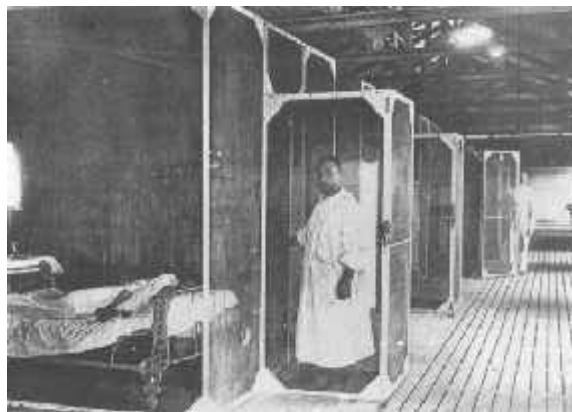
Foto 2: Chambres-marchoux. Quartos de tela metálica desmontáveis para isolar os acometidos por febre amarela.
